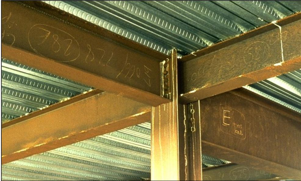
**Abbildung 1-2** Blick auf die ungeschützte Stahlstruktur
