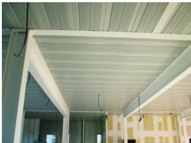
Soffit of Cofradal® Decibel
