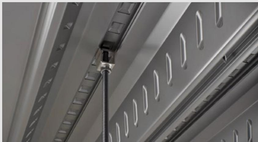
La géométrie en queue d'aronde du profil Cofraplus® 80, grâce à son Cofrafix 80, permet de suspendre directement des éléments tels que les réseaux électriques et de fluides ainsi que les faux-plafonds.
