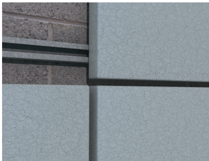
Illustration d'une façade formée de panneaux à cassettes en Granite® Quartz Photo : © ArcelorMittal
