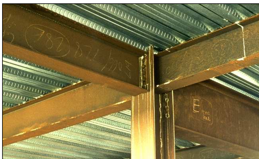
Figura 1.2 Estructura de acero sin proteger
