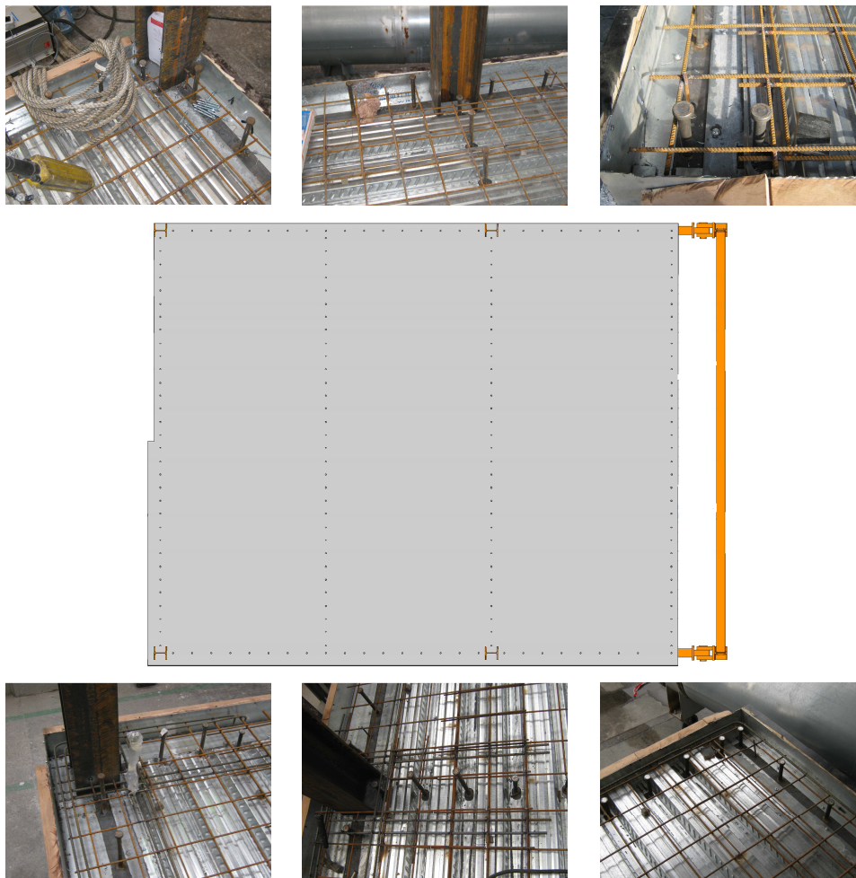
Figura 7.23 Diferentes configuraciones de unión mixta colaborante del acero y el hormigón
