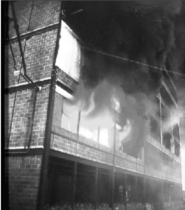
Figura 2.18 Vista externa del incendio
