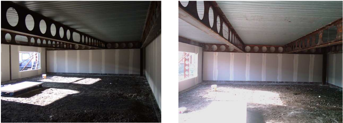
Figure 7.1 : Sector de ensayo con largas vigas alveolares desprotegidas
