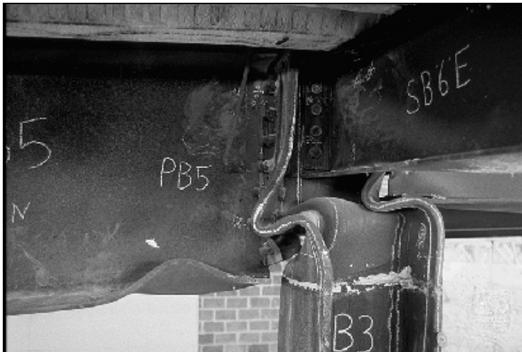
Figura 2.7 Capitel aplastado tras el ensayo
