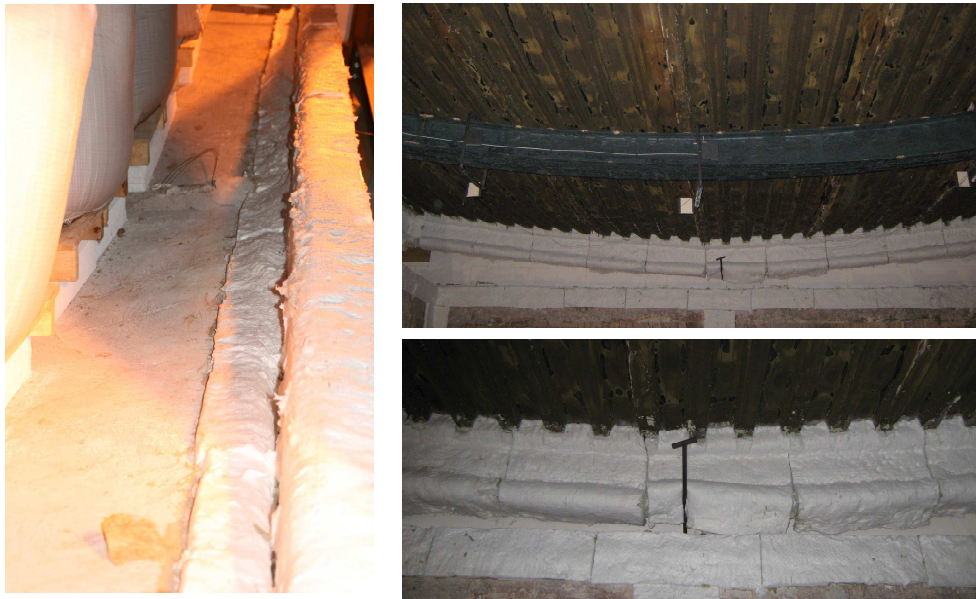
Figura 7.37 Colapso de viga de extremo
