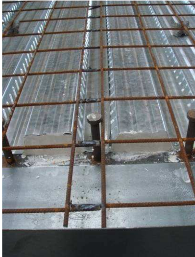
(a) Junta de armadura soldada antes del vertido de hormigón
