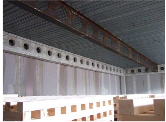
Figure 7.4 : Protección con fibra y paneles de yeso del interior del sector
