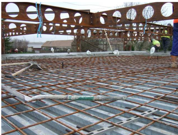
Figure 7.5 : Armadura y cubierta de acero previas al hormigonado
