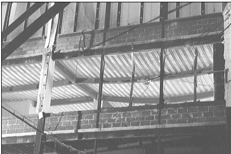
Figura 2.14 Estructura deformada durante el fuego
