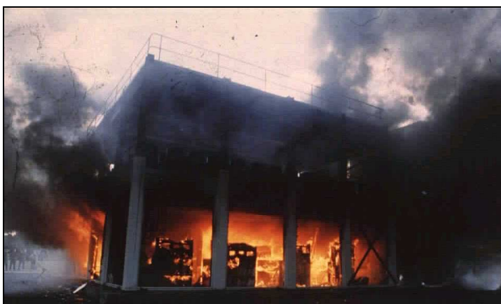
Figura 4.4 Edificio de ensayo BHP y ensayo de fuego
